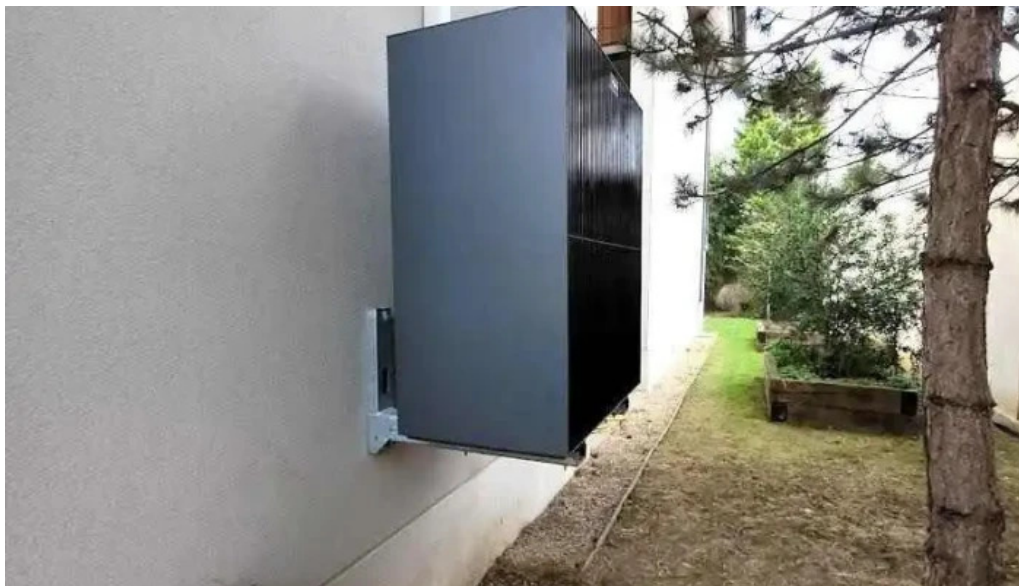
M energies service van kasteren pompe a chaleur et borne photovoltaïque kaerjeng
