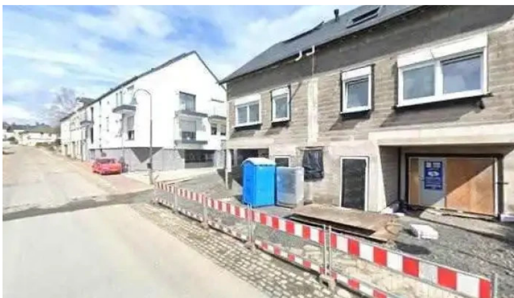
Key lock security sa street view 360deg fotos
