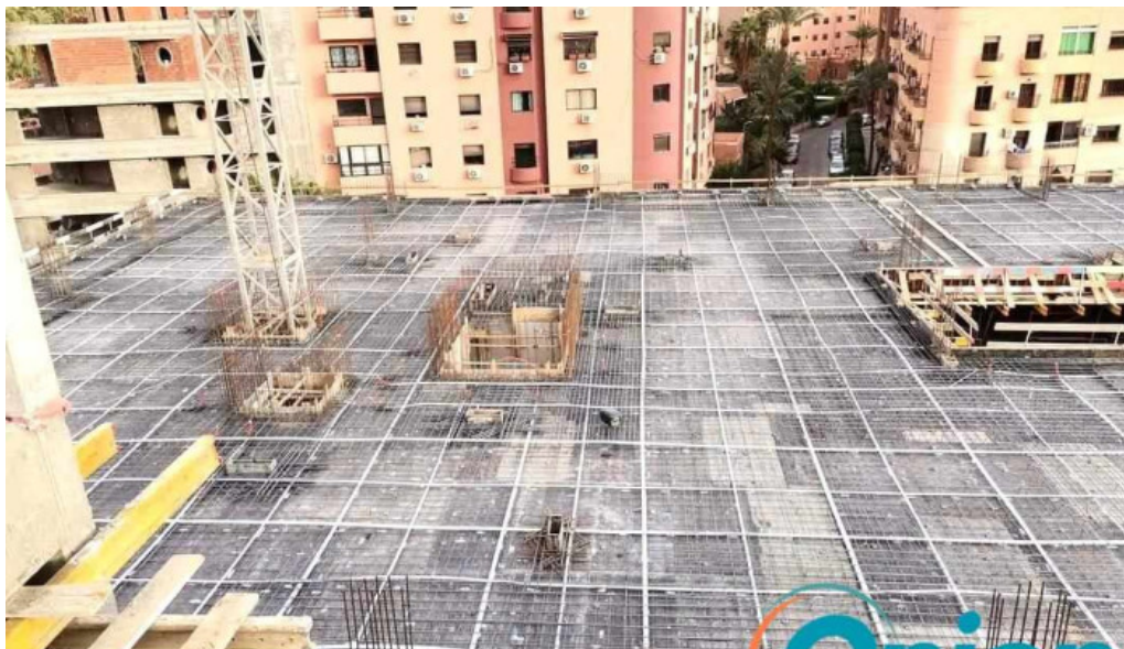
Gzl construction sarl aussenbereich
