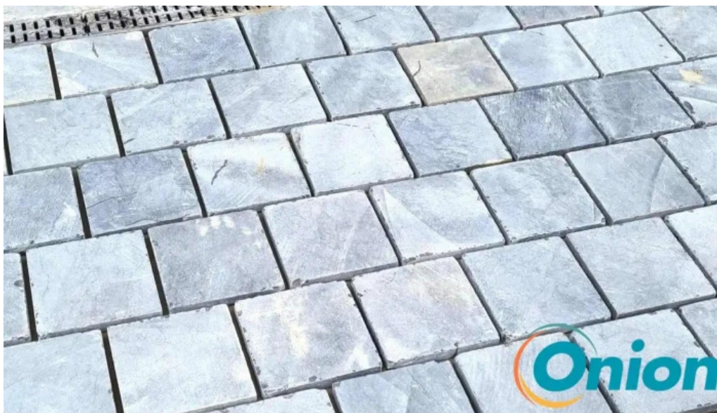
Et constructions renovations wiltz
