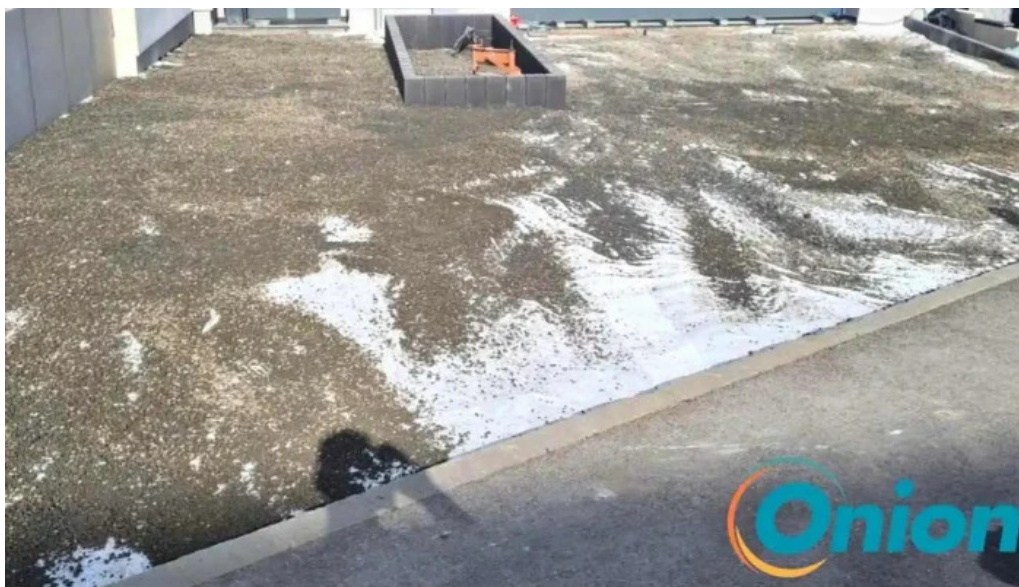
Et constructions renovations beton
