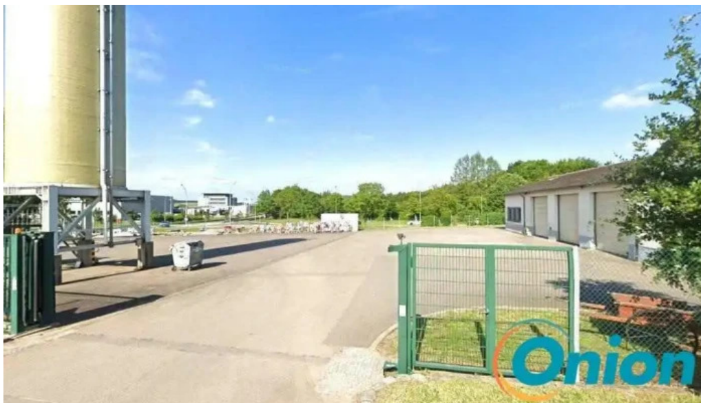
Atelier communal service de regie administration communale de schuttrange schuttringen
