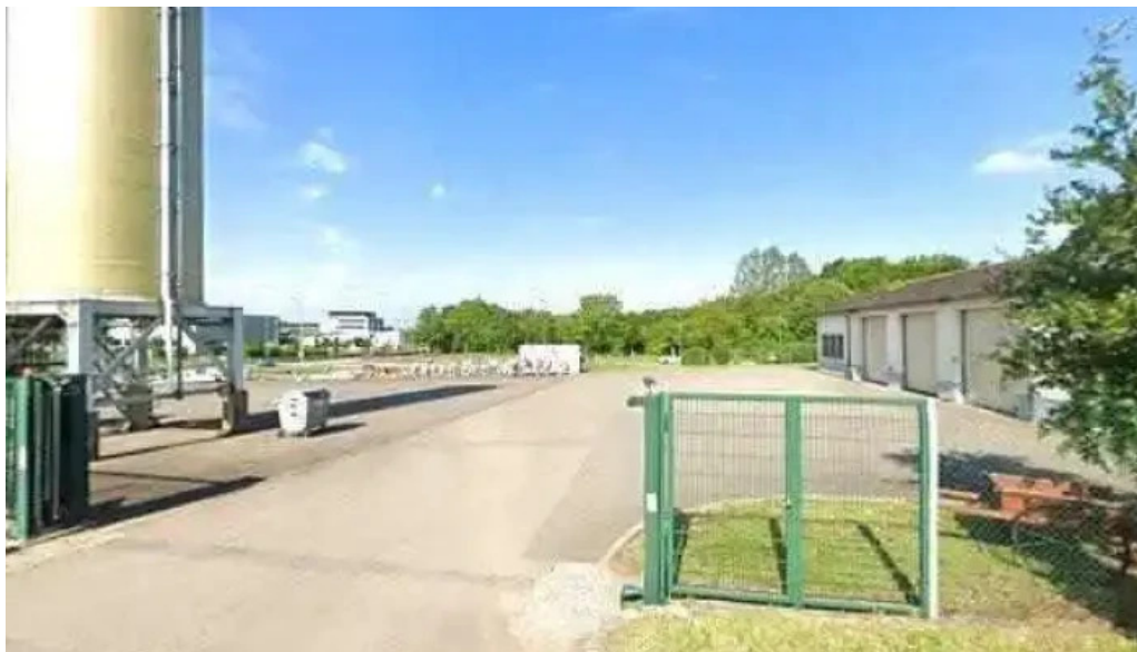
Atelier communal service de regie administration communale de schuttrange nummere
