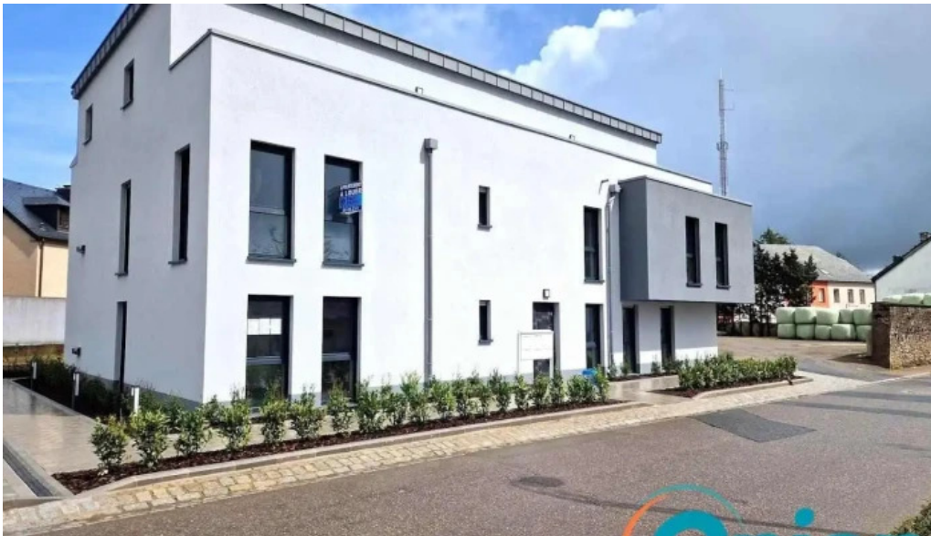
Entreprise de facades miotto romain et fils diekirch
