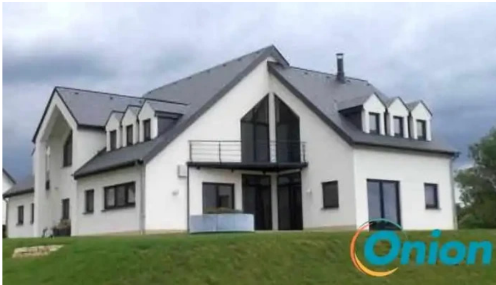
Toiture moderne ne s a r l colmar berg
