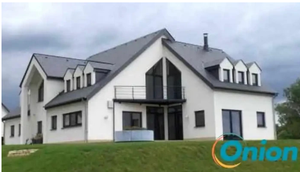
Toiture moderne ne sarl no bei mire
