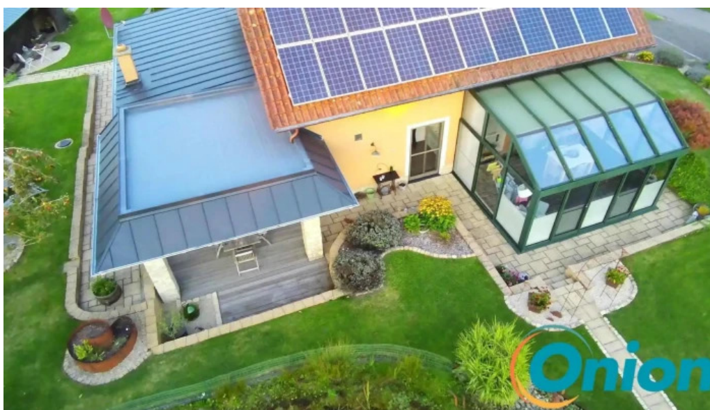
Toiture cfc next sarl haus
