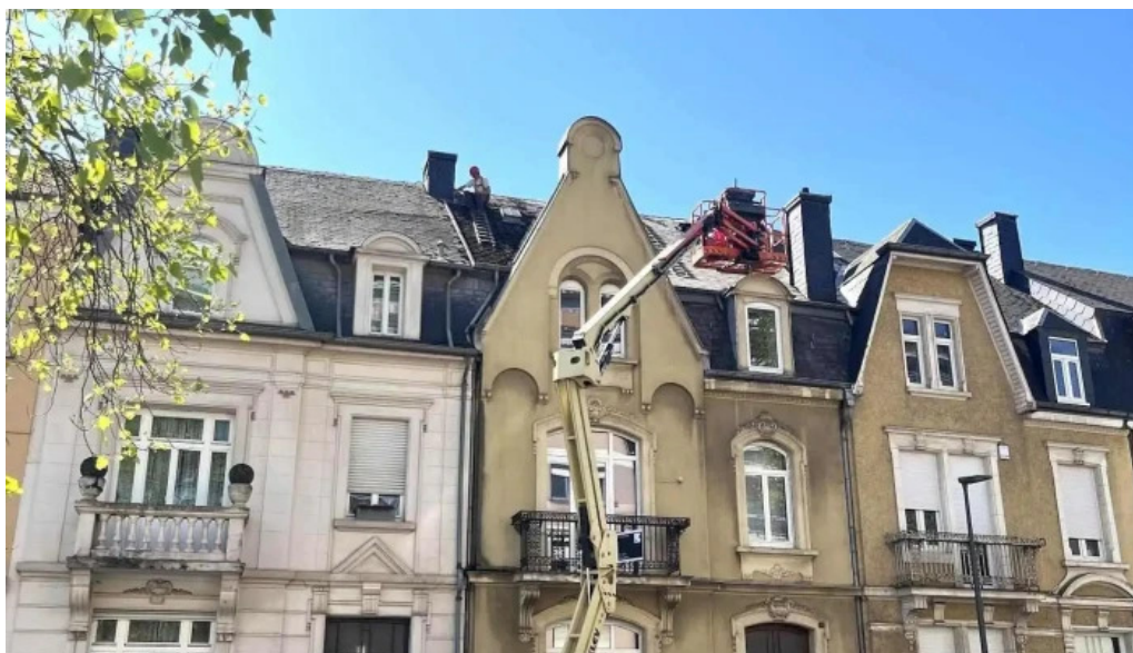
Toiture welter tony neueste
