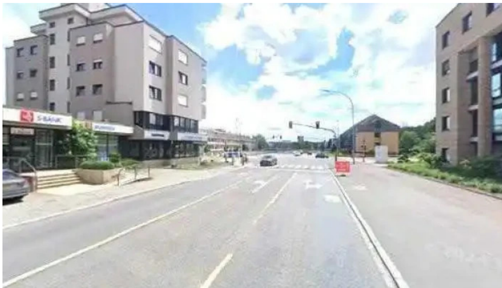
Menuiserie collin luxembourg sarl street view 360deg fotos
