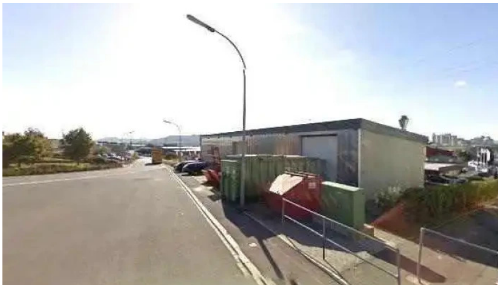
DI aménagement sarl street view 360deg fotos
