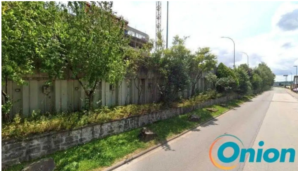
Electricite schaus sa ettelbruck
