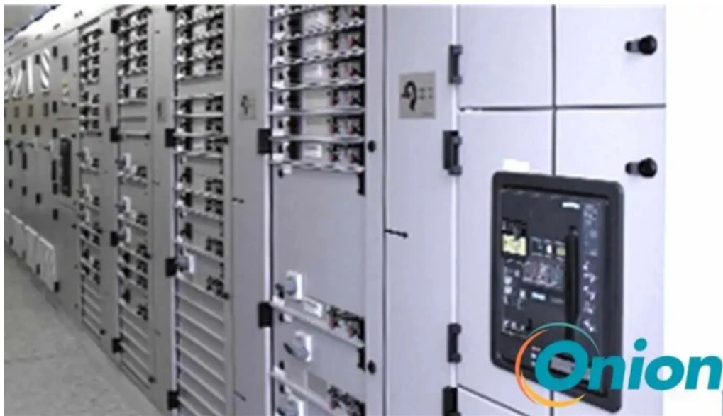
Kautz starkstrom anlagen luxemburg wei do ukommene
