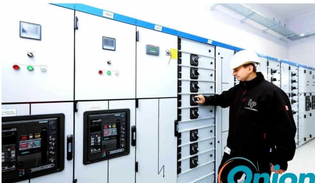
Lux power sarl electricite generale elektrotechnik stonnenplange
