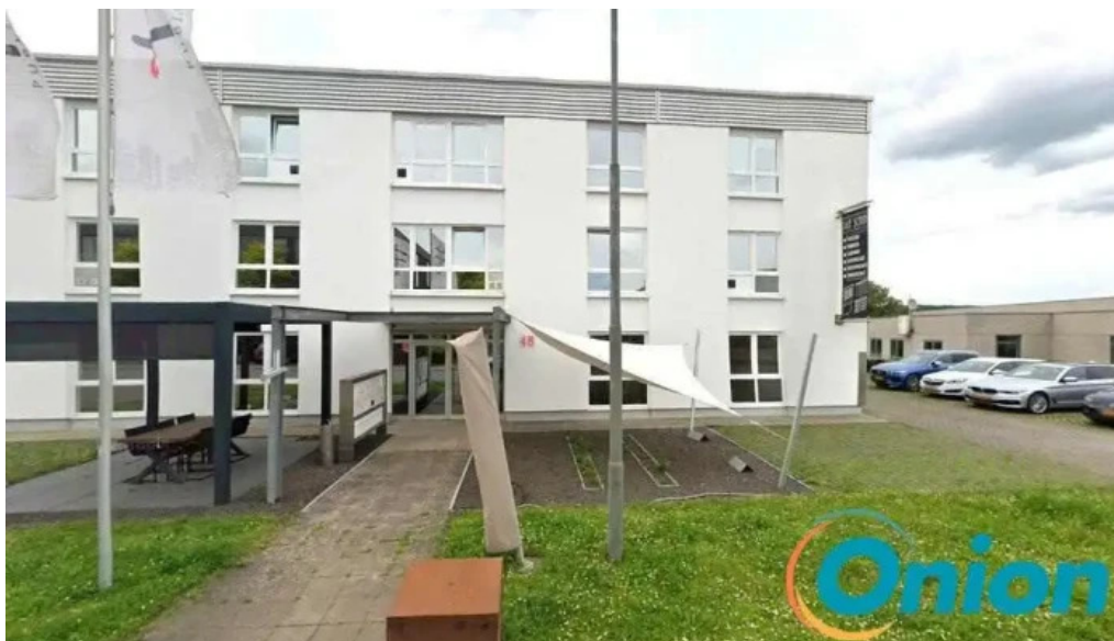
L electricien haag niederanven
