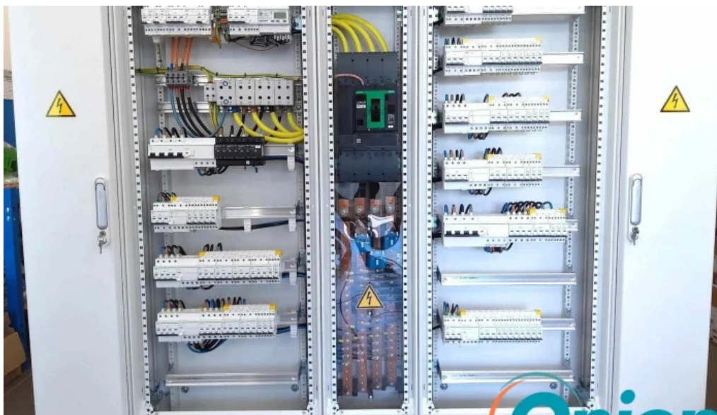
Cablux sa innenansichten
