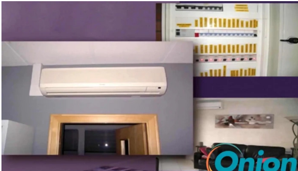
Luxembourg electricite foetz sa innenansichten
