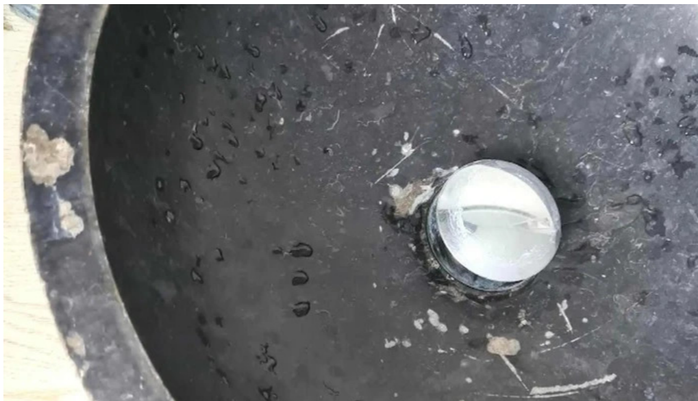
Rollinger chauffage sanitaire sa walferdingen
