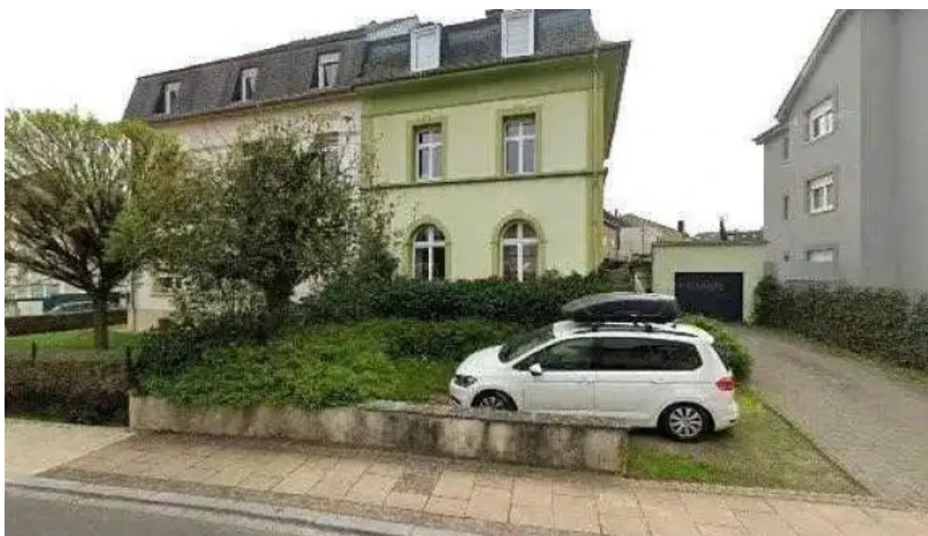
Chauffage sanitaire calorilux sarl street view 360deg fotos
