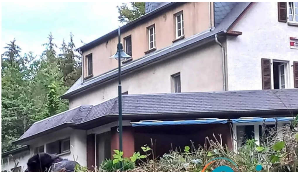
Hostellerie de la vallee aussenbereich
