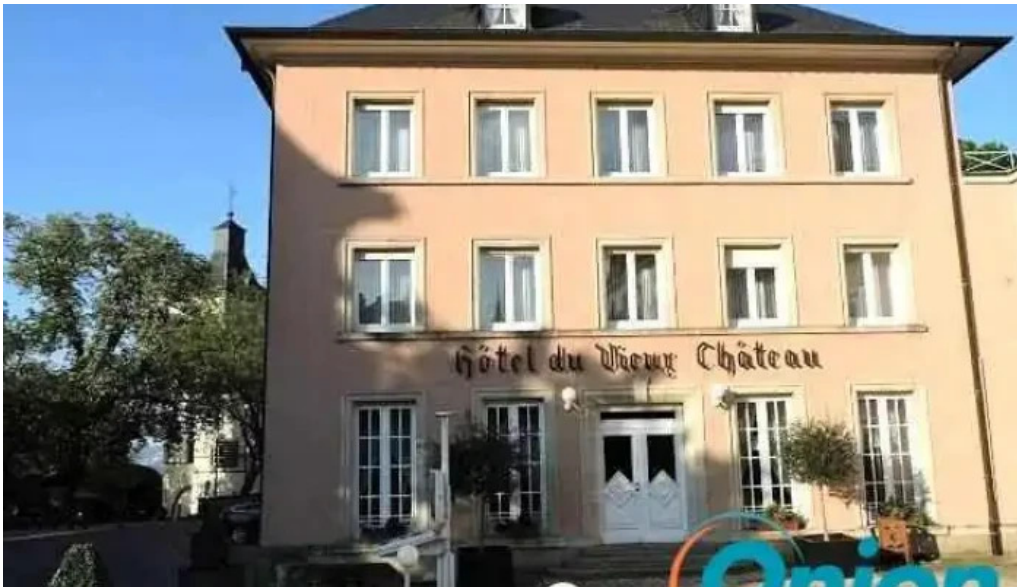
Hotel restaurant beim schlass wiltz
