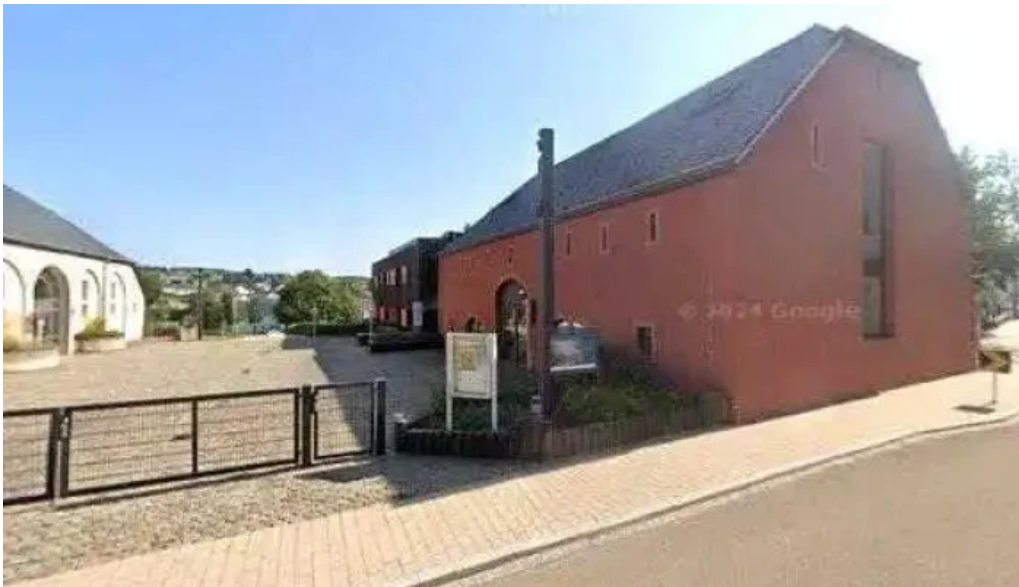
Maison relais grosbous arcus asbl stonnenplange
