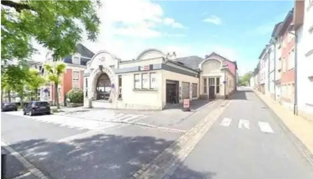
Bei den krunnemecken street view 360deg fotos
