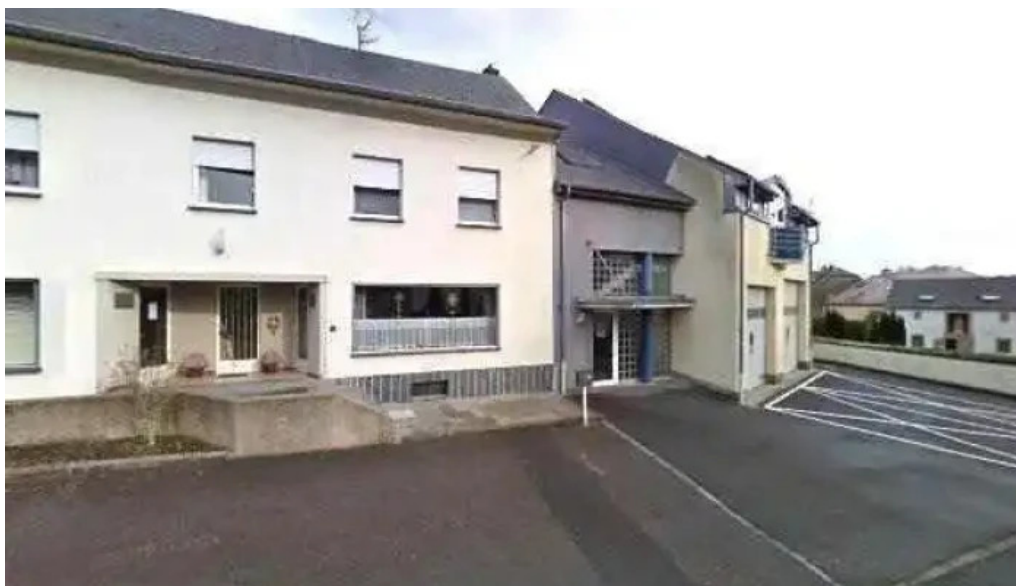
Administration communale de garnich cultural centre charging station bewaertunge
