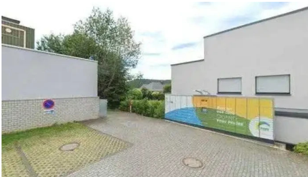
Chargy charging station no bei mire
