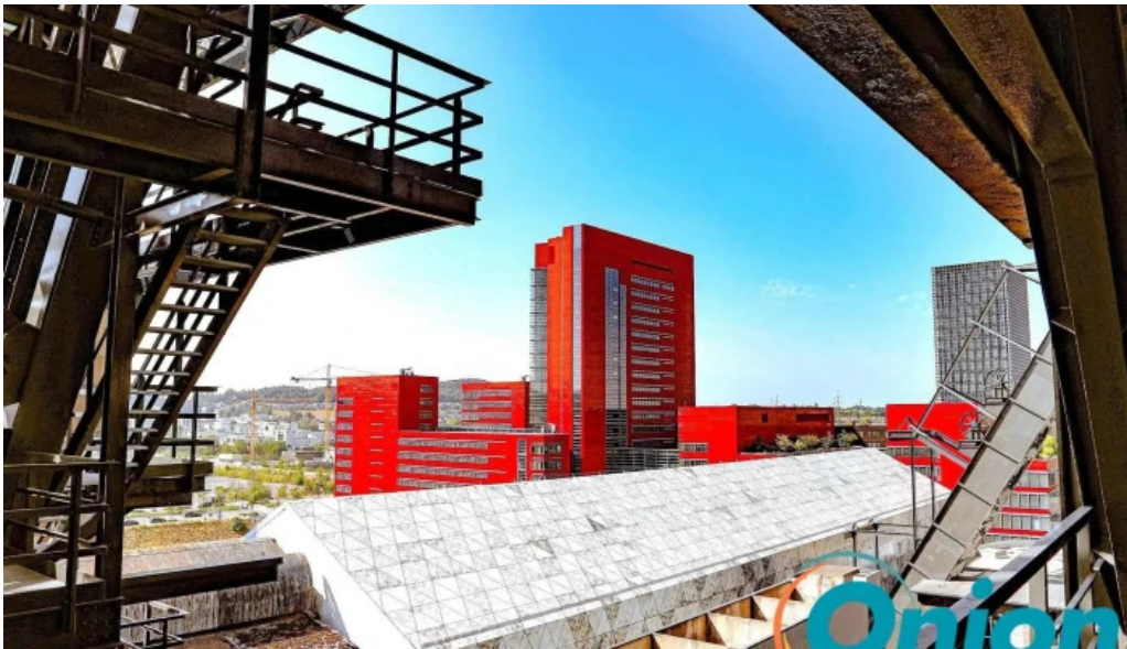
Les hauts fourneaux de belval adresse
