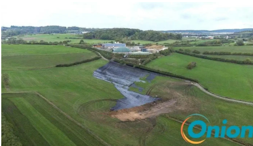
Lenster energie sarl telefone
