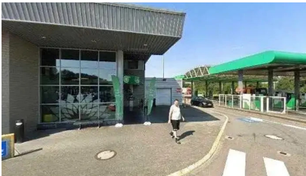
Aire de capellen sud street view 360deg fotos
