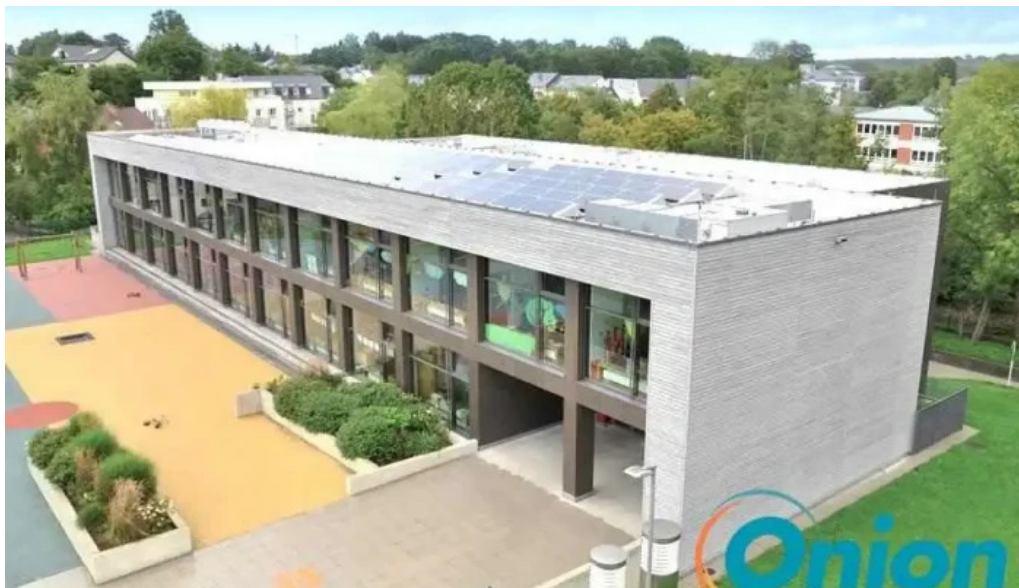
Maison relais steinfort steinfort
