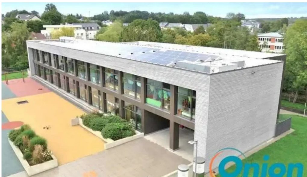
Maison relais steinfort bewaertunge
