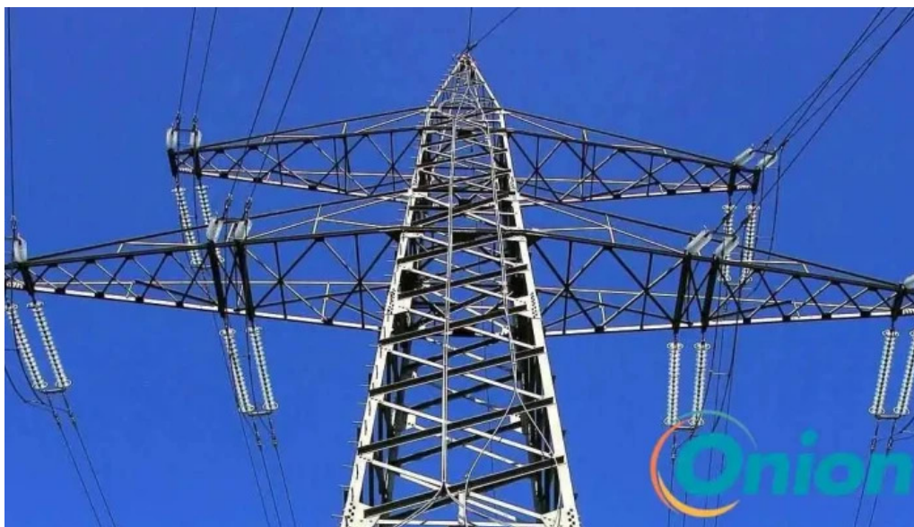
Creos centre de schifflange locatione
