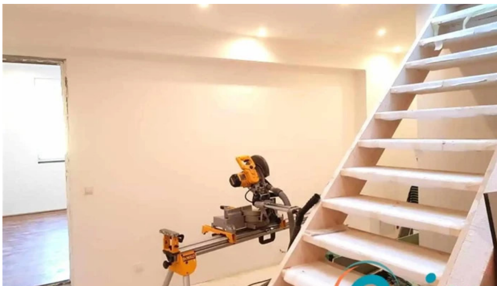
Rr renovation sarls kommentarene
